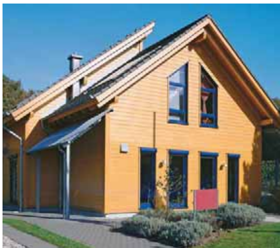
Freundlich: Der warme Ton der lasierten Holzfassade wirkt auf Passanten und Besucher sehr einladend.
