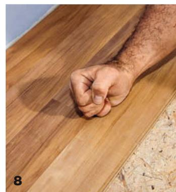
**1** Die wandseitigen Laminatdielen schieben Sie über die kurzen Kantenprofile ineinander.
