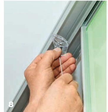
**1** Die fertige Gleittür hängen Sie zunächst an einem Ende der Nische locker in eine Spur der Deckenschiene ein.
