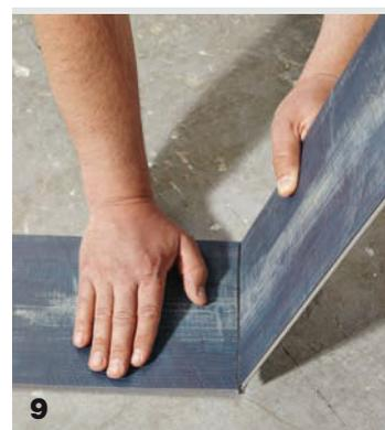
**7** Schneiden Sie mit einem scharfen Cutter oder Teppichmesser und unter Zuhilfenahme eines metallenen Tischlerwinkels oder einer Schneidesebene die Vinyl diele ein.
