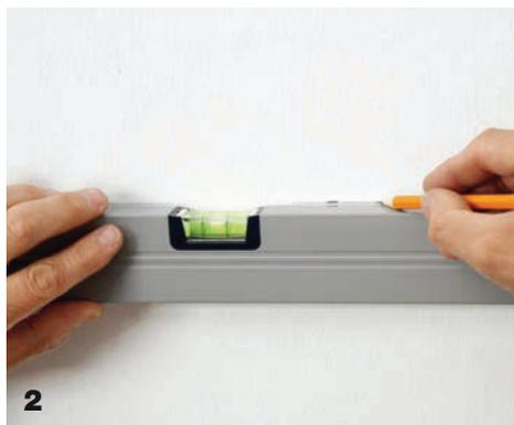
**2** Die Länge der Bordüre mithilfe einer Wasserwaage entlang der markierten Punkte mit Bleistift anzeichnen.
