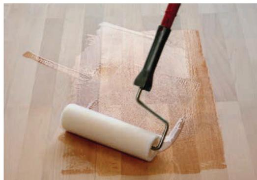
Die fachgerechte Versiegelung mit **AQUA CLOU Treppen+ Parkett Versiegelungslack** schützt Echtholzböden, rohe Korkböden und Treppen gegen das Eindringen von Schmutz und Flüssigkeiten sowie gegen Abrieb. Durch den sorgfältigen Auftrag und eine gleichmäßige Verteilung mit der **Profi-Wasserlackrolle** wird die Holzoberfläche gut versiegelt und Farbton sowie Maserung schön hervorgehoben.
