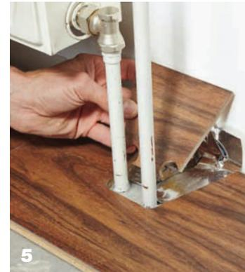
**1** Die PE-Folie, die als Dampfbremse fungiert, muss natürlich auch im Bereich der Heizungsrohre liegen.
