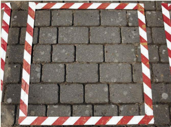
**1 + 2** Die Spritzlösung wird am besten literweise angemixt. Je nach Verschmutzungsgrad sind das 100 bis 200 ml auf einen Liter Wasser. Benutzen Sie zur Dosierung die Markierung an der Flaschenseite.
