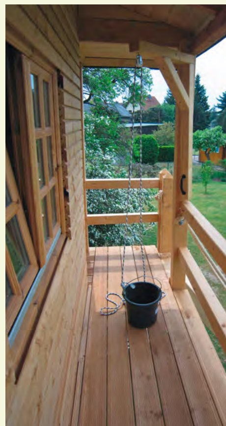
Die Veranda ist 90 cm breit und verläuft über zwei Hausseiten. Der Lastenaufzug funktioniert über einen drehbaren Galgen, der zwischen Brüstung und Dach montiert ist.
