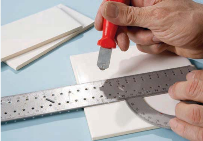
DER EINFACHE HANDSCHNEIDER mit Hartmetallschneiderädchen und einem Stahlwinkel als Anschlag eingesetzt, reicht für gerade Schnitte an Steingutwandfliesen aus.
