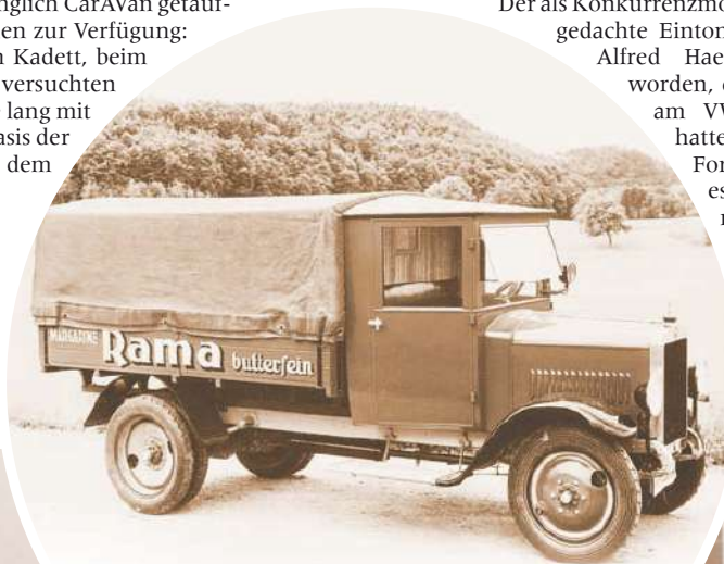
Zwischen den Weltkriegen nicht wegzudenken von Deutschlands Straßen: Last- und Lieferwagen für den Verteilerverkehr. Hier ein Mercedes L1 von 1926, der erste Transporter mit Dieselmotor. Zuladung: zwei Tonnen.
