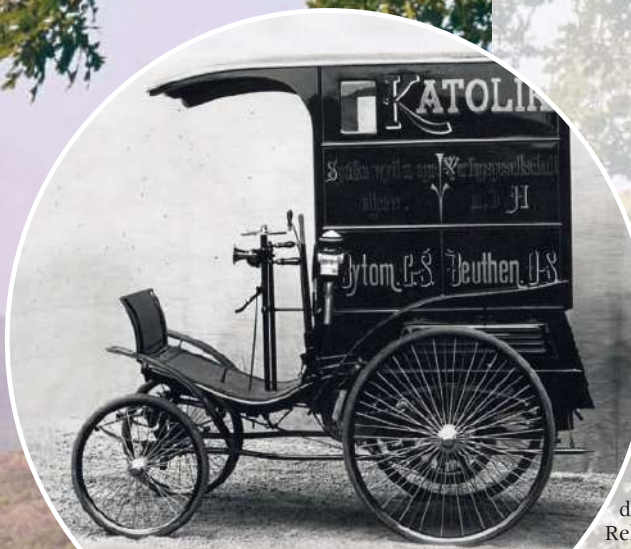
Der Vater aller Vans: Mercedes-Zweisitzer-Kutschierwagen, abgeleitet vom Benz „Velo“, mit Kettenantrieb und abnehmbarem Kasten.
