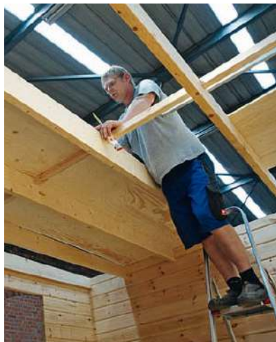
Das Hausdach trägt das Oberdeck, deshalb ist es flach konstruiert und liegt auf aufrechten Lagerhölzern. Jörn Wohler misst die Platten ein.
