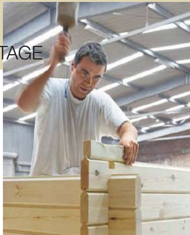
Die Feder muss heil bleiben, deshalb setzt Zimmermann Andreas Decker den Schlagklotz auf, um nicht auf das vorgefräste Bauteil zu schlagen.
