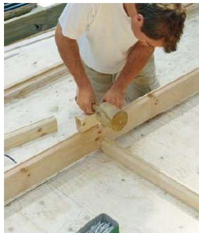
Die Kajütwände sind aus Massivholz und im Stecksystem konfektioniert. Die Teile werden mit dem Klüpfel zusammengetrieben und genagelt.
