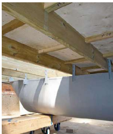
Die beiden Schwimmer aus Stahl sind strömungsoptimal geformt. An den geschweißten Stahllaschen werden die Decksbalken festgeschraubt.
