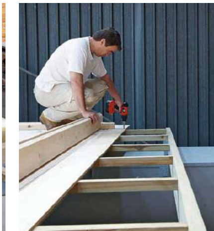
Der Unterbau des Hausboots mit den Planken ist verrottungsresistent ausgerüstet – wichtig, da es hier immer wieder Kontakt zum Wasser gibt.
