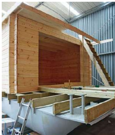
Das Vordeck wird beplankt. Auf die aufrechten Decksbalken werden die Planken direkt aufgeschraubt, die Poller zum Festmachen ausgespart.
