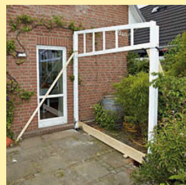
Seitenrahmen fixieren, Fundamente ausbetonieren.
