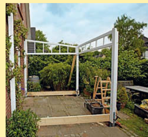
Vom ersten Seitenrahmen aus den Rest einmessen.
