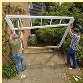
Seitenrahmen inklusive Wandpfosten aufstellen.
