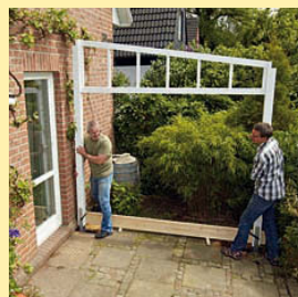
In den Fundamentlöchern ausrichten, Wandloch bohren.
