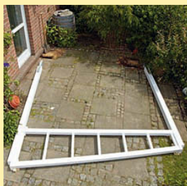
Die zwei Seitenrahmen vormontieren und auslegen.
