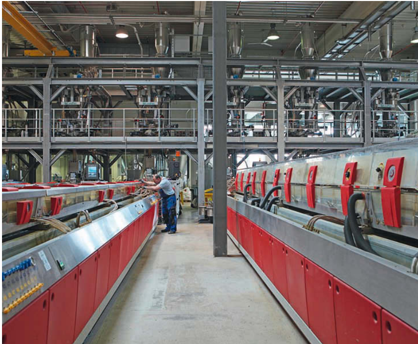
Produktionsstraße. Mehrere solcher Anlagen (Foto oben) stehen im Werk Bruchsal nebeneinander. Das erhitzte Holz-Kunststoff-Gemisch kommt 200°C heiß aus den Refraktoren im Hintergrund. Jetzt wird es gleich in Form gebracht.
