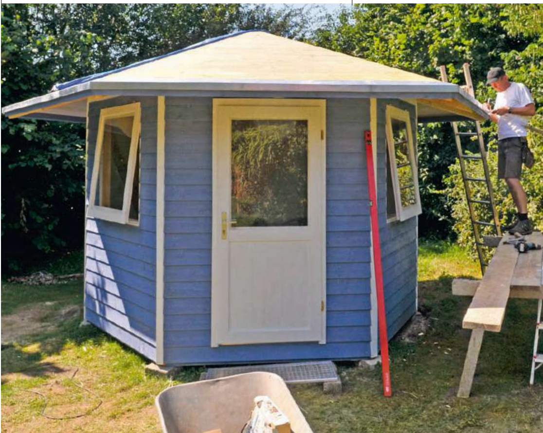
Gut gelüftet: Die Fundamente sorgen für reichlich Bodenfreiheit; sie sind nach außen abgeschrägt, damit Wasser abläuft.
