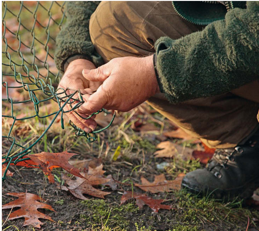
Test: Wo ein Fuß nicht durchpasst, hat auch ein Wildschweinerüssel keine Chance; jedenfalls wenn der Zaun tief im Boden verankert ist, einen massiven Querschnitt hat und aus Hartholz (Eiche) gebaut ist. Ein einfacher Maschendrahtzaun, der gerade bis zum Boden hinunter reicht, genügt nicht. Kommt der Rüssel erst bis Augenhöhe unter den Zaun, ist der Weg fürs Wildschwein frei.
