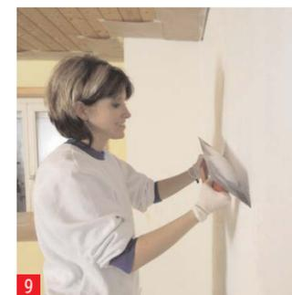
Sobald die Sandgrundierung trocken ist, kann der Verputz mit einer Stahlglättkelle aufgetragen werden.
