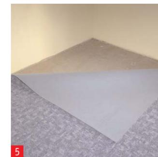
5 Der Teppich ist nun dem Fussboden entsprechend zugeschnitten und kann verklebt werden.
