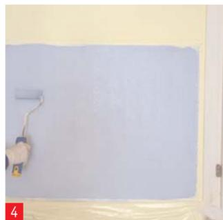
4 ...kleben Sie diese sorgfältig ab. Tragen Sie nun die Magnetfarbe nach Gebrauchsanweisung schichtweise auf.
