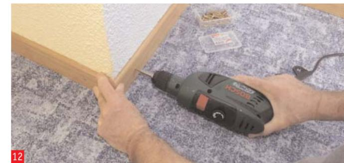
12 Achten Sie beim Zuschritt der Fussbodenleisten darauf, dass diese exakt auf Gehrung geschnitten sind.
