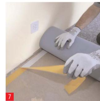
7 Ziehen Sie nun die Schutzfolie des Klebebandes ab und positionieren Sie den Teppich exakt darauf.
