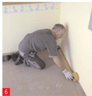
6 Kleben Sie Doppelseitiges Klebeband an den Rändern des Bodens entlang.
