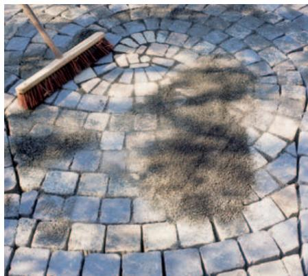
**12** Wenn alle Steine liegen, muss Sand oder – wie hier – Splitt in die Fugen eingefegt werden, um das Pflaster in seiner Lage zu stabilisieren.
