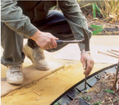
**7** Das Randprofil wird der Form des Weges entsprechend – gerade oder im Bogen – ausgelegt und mit 30-cm-Nägeln im Boden fixiert.
