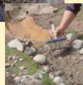
Die aufwendigste, aber auch gestalterisch freieste Art des Bachlaufbaus ist die Arbeit mit Beton und eingelegten Kieselsteinen. Aufwendig ist das deshalb, weil Sie trotzdem noch eine Folie auslegen und mit einem
