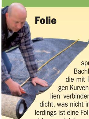
Die flexibelste, aber auch die handwerklich anspruchsvollste Art der Bachlaufgestaltung ist die mit Folie. Grund: Bei engen Kurven müssen Sie zwei Folien verbinden, und das wasserdicht, was nicht immer einfach ist. Allerdings ist eine Folie so dünn, dass sie nachher unsichtbar unter der Bachrand- und -bettdekoration verschwindet. Sie ist also die Lösung für Ästheten. Folien kosten in der guten, besandeten Ausführung etwa 18 Euro pro qm, als einfache PVC-Rollenware ab 4 Euro/qm.
