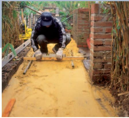
**3** Zwei Eisenrohre dienen als Führung beim Abziehen des Sandbetts. Mit der Wasserwaage werden sie mit etwa 2 % Gefälle ausgerichtet.
