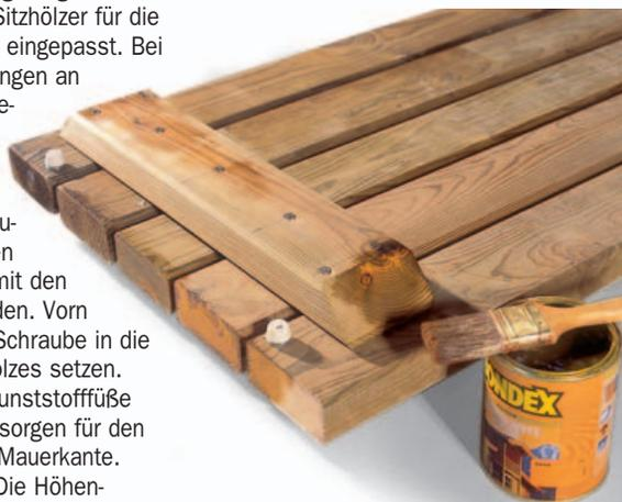
**Weil bei Schnittkanten** die Schutzwirkung der Druckimprägnierung nicht mehr gegeben ist, trägt man dort grundsätzlich einen Holzschutz auf.
