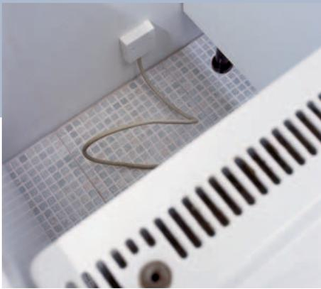
**2** Zuerst wird der Herd abgerückt. Die Stromzufuhr wird am Sicherungskasten unterbrochen und das Anschlusskabel aus der Dose gelöst!
