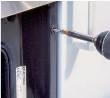
**14** Oben links und rechts wird der Backofen an den Schrankkorpuswänden mit Spanplatten-schrauben festgeschraubt.
