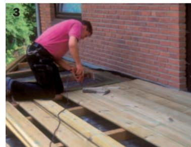
**3** Die Bodenbretter werden an der Hausseite beginnend auf die Lagerbalken geschraubt. Schmale Fugen garantieren, dass Regenwasser schnell abläuft. Leistenabschnitte sorgen für gleichmäßige Abstände.
