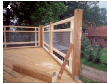
**4** Für das Geländer werden Kanthölzer als Pfosten mit Winkeln oder Pfostenschuhen am Ringanker verschraubt, dann die Zaunfelder dazwischengesetzt. Diese sind aus Kanthölzern und verzinktem Drahtgitter selbstgebaut.
