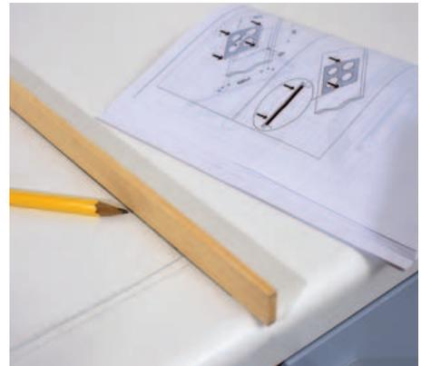
**8** Tipp: Mit Hilfe einer 5-mm-Leiste wird diese Schnittlinie nach innen versetzt angezeichnet. In diesem Bereich liegt später das Kochfeld auf.
