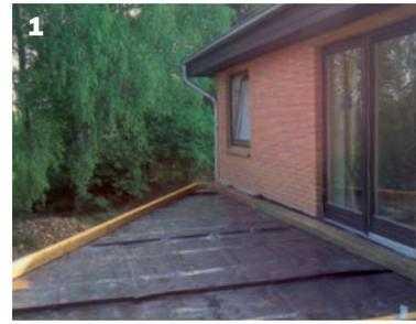
**1** Das Dach des Anbaus ist mit Teerpappe abgedeckt. Zusätzlich schützt eine Dichtungsbahn (zum Beispiel Teichfolie) die Dachhaut. Ein Ringanker aus Kanthölzern wird an den Außenmauern befestigt.
