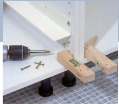
**4** Die Seitenwände der Schränke kantenbündig ausrichten, mit einer Momentzwinde festspannen und mit Spaxschrauben verbinden.
