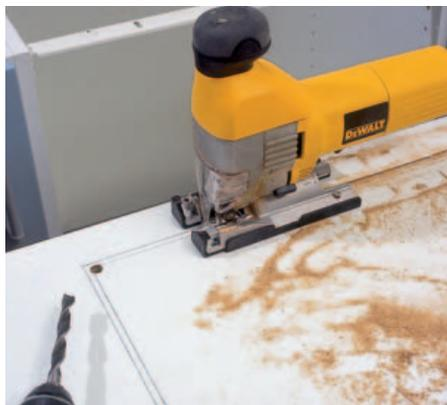
**9 Mit der Elektrostichsäge** wird der eingezeichnete Bereich ausgesägt. 10-mm-Löcher in den Ecken helfen, eine saubere Kurve zu sägen.
