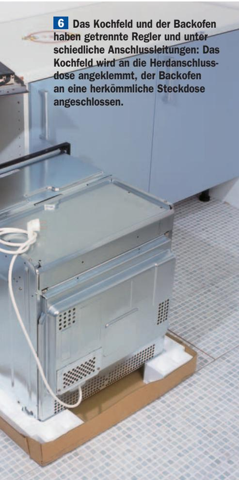
**6** Das Kochfeld und der Backofen haben getrennte Regler und unterschiedliche Anschlussleitungen: Das Kochfeld wird an die Herdanschlussdose angeklemmt, der Backofen an eine herkömmliche Steckdose angeschlossen.
