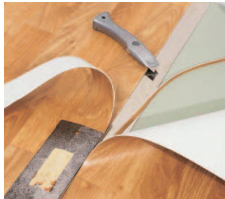
8 Beim Verlegen von mehr als einer Bahn führt man einen deckungsgleichen Schnitt an den Kanten durch beide Bahnen aus (Lauftext).
