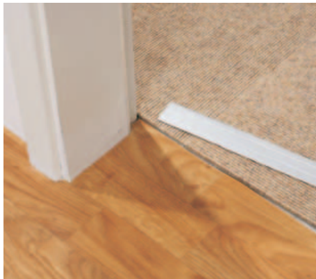
7 Die Übergänge zu anderen Materialien (hier zu einem Teppich) werden am einfachsten mit Übergangsschienen zum Aufkleben hergestellt.
