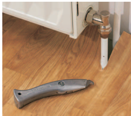
11 Bei Heizungsrohren wird der PVC-Boden zunächst gerade eingeschnitten und dann anschließend kreisrund herausgearbeitet.
