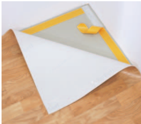
6 Die fertig zugeschnittenen Böden können nun mit dem vorbereiteten Klebeband von den Raumecken aus beginnend fixiert werden.
