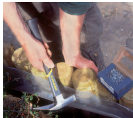
10 Eine Kunststoffolie zwischen Erdreich und Palisade genagelt, verhindert, dass Sand durch die Palisadenzwischenräume rieselt.
