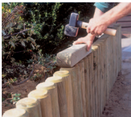
9 Mit einem Klopffholz (Restabschnitt) und einem Hammer (mit Gummischutz) wird die Palisade auf eine einheitliche Höhe gebracht.
