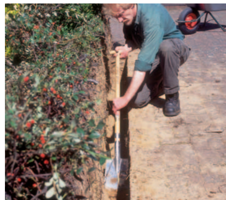
5 Der Grabenboden wird mit dem Spaten geebnet. Beachten Sie, dass die Grabenwände exakt gerade und nicht schräge (v-förmig) sind.
