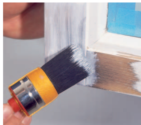
8 Rohes Holz und ausgespachtelte Stellen mit einer Grundierung deckend streichen und nach dem Trocknen nochmals anschleifen.
