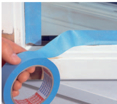
7 Glasscheiben und Silikondichtungen mit einem speziellen Klebeband für Fenster gegen unbeabsichtigte Pinselftriche schützen.
