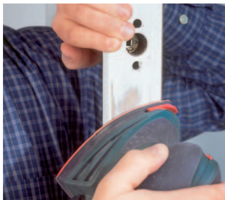
4 Die breiten Rahmen- und Flügelkanten schleifen Sie am besten mit einem Dreiecksschleifer mit 180er-Schleifpapier.
