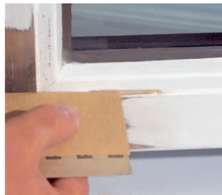
5 Schmale Kanten und Innenecken werden per Hand angeschliffen. Beachten Sie dabei, dass die Glasversiegelung nicht verletzt wird.
