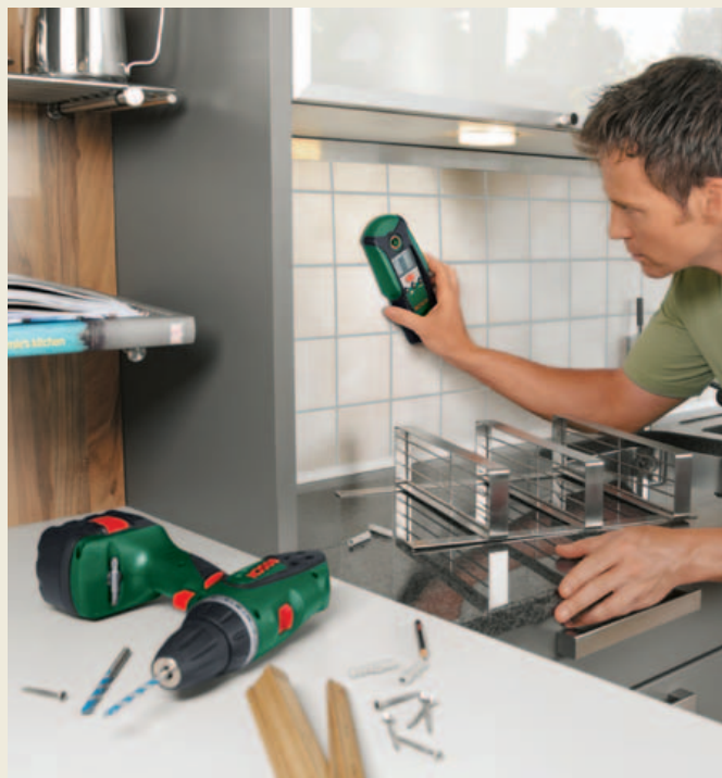
Vor dem Bohren gilt es, die Bohrstelle auf Leitungen und störende Armierungsseisen zu untersuchen.
