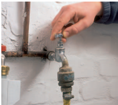
17 Wasserschlauch an den KFE-Hahn (Bild 3) schrauben und den Wasserkreislauf wieder auffüllen. Verschraubungen auf Dichtheit prüfen.
