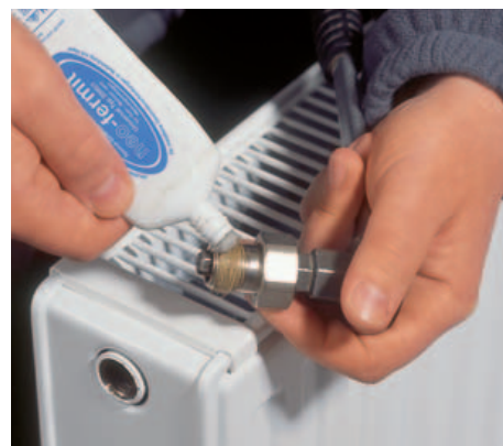
10 In der Zwischenzeit wird der neue Heizkörper mit Anschlüssen versehen. Wie man die Dichtung mit Hanf richtig anlegt siehe Seite 52.
