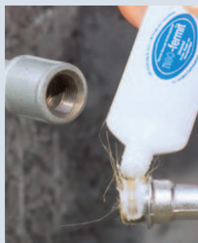
Die Dichtungsmasse (Marke Neo-Fermit) auftragen und mit dem Finger rundherum verteilen, bis der Hanf davon fast durchtränkt ist. Anschließend Gewinde aufdrehen und nicht mehr rückwärts schrauben.
