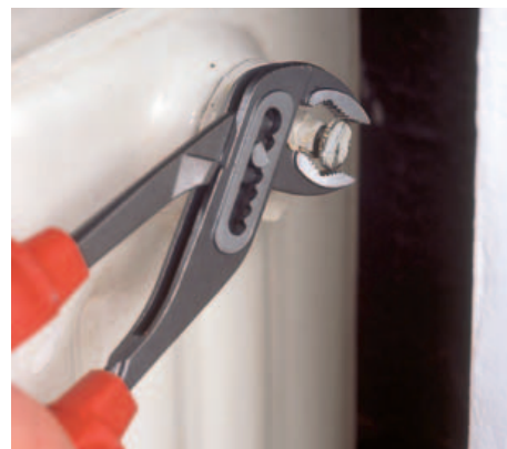
5 Die Entlüftungsschraube am Heizkörper mit einer Rohrzanze komplett öffnen, so dass Luft in den Heizungswasserkreislauf gelangen kann.
