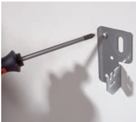
12 Die Wandhalterungen werden vorerst mit nur einer Schraube montiert. Restliche Schrauben erst nach dem Justieren befestigen.
