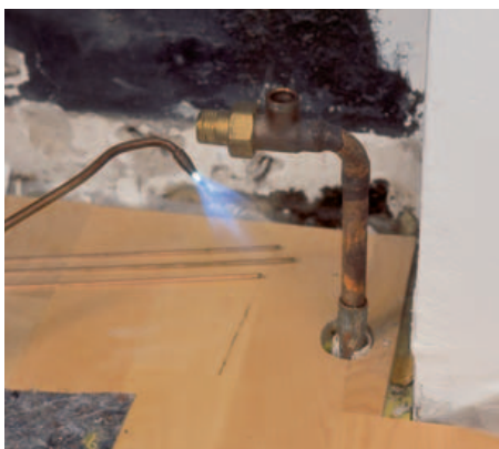
9 Müssen Anschlüsse verlegt werden, weil der neue Heizkörper andere Maße hat, so lassen Sie diese Arbeit nun vom Fachmann verrichten.
