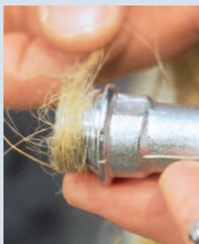
Ein dünner Hanfstrang wird erst ein- bis zweimal links herum (gegen die Drehrichtung), dann rechts herum auf das Gewinde gewickelt. Erhabene Teile des Gewindes müssen noch deutlich zu fühlen sein.
