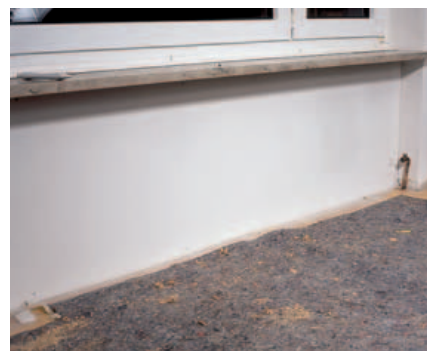
Als sauberen Abschluss schraubt man eine weiß lackierte, 25 mm dicke Multiplexplatte auf das Ständerwerk. An dieser Platte wird dann später der Heizkörper befestigt.
