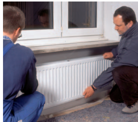
13 Der neue Heizkörper wird vorsichtig mit einem Helfer in die Halterungen eingehängt und nach den Rohranschlüssen ausgerichtet.
