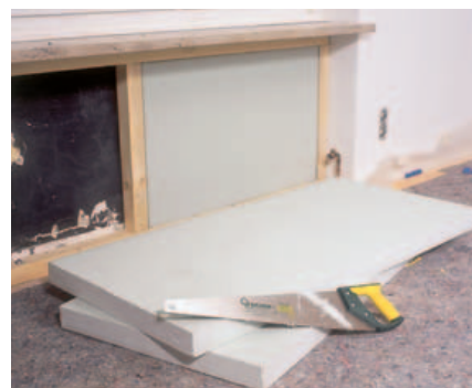
Das Dämmmaterial (in unserem Falle Hartschaum) sägt man mit einer einfachen Handsäge so knapp zu, dass die Platten stramm in die dafür vorgesehenen Kammern passen.
