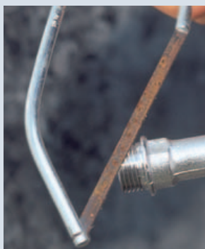
Das Gewinde wird diagonal mit einer Eisen- oder Puksäge aufgeraut, falls dies nicht schon werksseitig vorgefertigt ist. Die so entstandenen scharfen Kanten bieten dem Hanf einen guten Halt.
