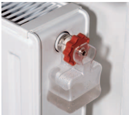
19 Zuletzt an der Entlüftungsschraube die Luft aus dem Wasserkreislauf entfernen. Der kleine Behälter fängt dabei mitlaufendes Wasser auf.
