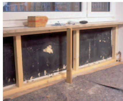
Aus kräftigen Vierkanthölzern wird ein Rahmen gefertigt, in dessen Kammern später das Dämmmaterial gesteckt wird. Die Hölzer werden seitlich und am Boden verdübelt.
