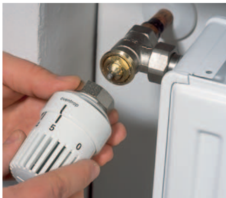
16 Das Thermostatventil ganz öffnen (es lässt sich so leichter auf den Metallstift stecken), aufdrehen, mit dem Rollgabelschlüssel festziehen.
