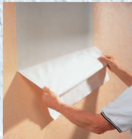
So soll es sein: Von einer gut grundierten Gipsbauplatte lassen sich alle Tapetenarten in einem Stück wieder abziehen.
