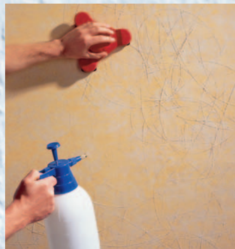
So nicht: Auf Gipskartonwänden ist der Einsatz einer Tigerkralle zum Perforieren nicht ratsam, weil Sie den Karton der Platte mit aufreißen.
