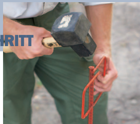
1 Ist der Verlauf des Weges festgelegt, und sind alle Kurven eingeplant, werden die stählernen Sticken an den Eckpunkten eingeschlagen.
