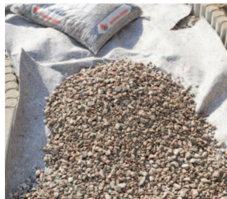
13 Zuletzt füllt man den Kiesbelag in entsprechender Farbe und Form bis etwas unterhalb der Rasensteinkanten ein.
