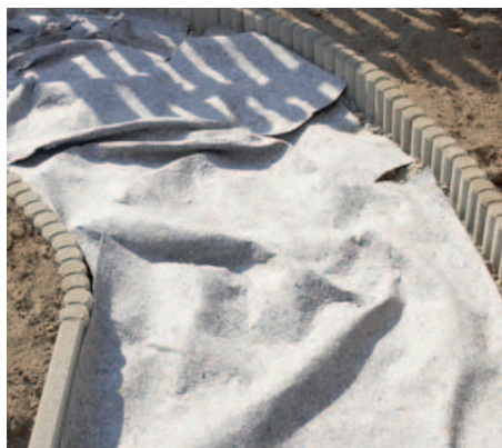
12 Eine Lage Gartenvlies zwischen der Mittel- und der Oberschicht verhindert, dass Gras und Kräuter von unten durch den Kiesweg wachsen.
