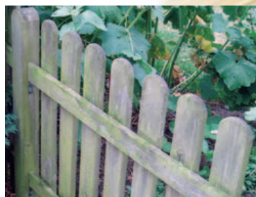
Der Algenbewuchs auf Zäunen hält die Feuchtigkeit und beeinflusst somit die Zerstörung des Holzes positiv.
