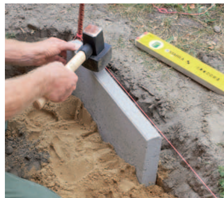
6 Die seitliche Begrenzung übernehmen Rasenkantensteine, die in ein Kiessandbett eingegraben und festgeschlagen werden.
