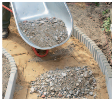
11 Als Mittelschicht wird etwa 7 bis 10 cm hoch ein Mineralgemisch mit der Körnung 16/32 auf der Wegefläche verteilt.
