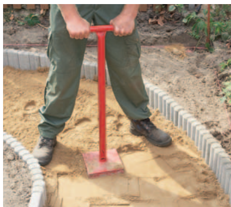
10 Nun mit einem Verdichter , einer Art Stempel mit schwerer metallener Grundplatte, den Sand per Hand gründlich feststampfen.
