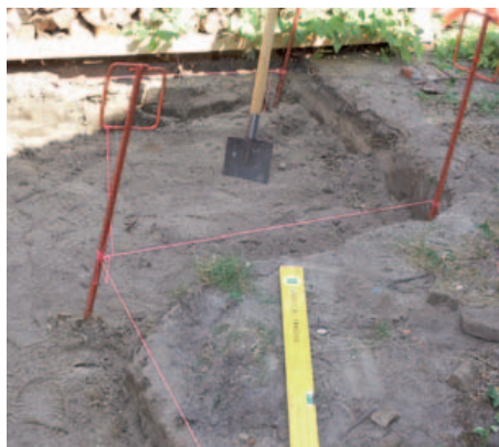
5 Die Wegefläche hebt man 15 bis 20 cm tief aus und schafft der Aushub beiseite oder lässt ihn von einem Containerdienst abfahren.
