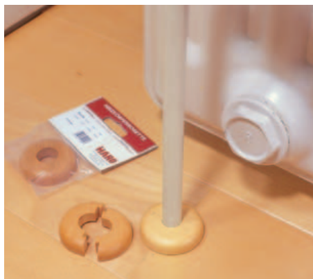
29 Für die Durchführungen der Heizungsrohre gibt es Heizkörperrosetten in Holzfarbe. Die lassen sich einfach zusammenstecken.
