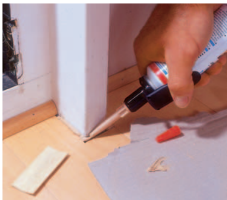
28 Die Fugen zu nicht nagel- oder schraubbaren Bauteilen (Stahlzarge) füllen Sie mit dauerelastischer Acrylmasse in Holzfarbe aus.
