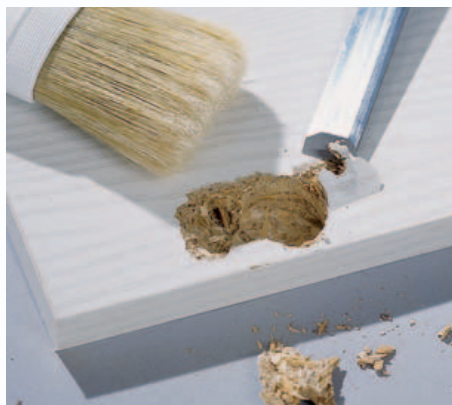
1 Türseite: Lose und eingerissene Teile werden mit dem Stecheisen herausgearbeitet, Holzspäne und Schmutz mit dem Pinsel entfernt.
