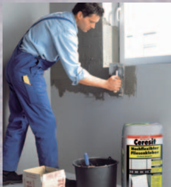
Der klassische Baukleber ist Fliesenkleber, der durch Kunststoffzusätze kinderleicht zu verarbeiten ist.
