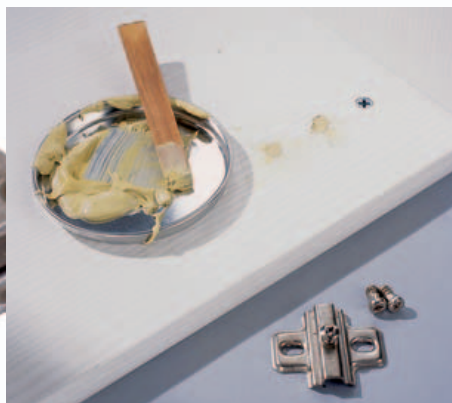
A Korpusseite: Sind die Schraublöcher von Montageplatten ausgebrochen, werden auch sie mit Zweikomponenten-Holzpaste verfüllt.
