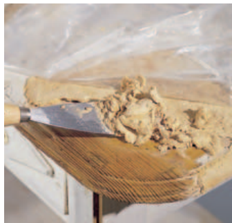
Abbeizmittel lösen auch mehrere Lackschichten auf einmal an, der gelöste Lack ist aber Sondermüll.
