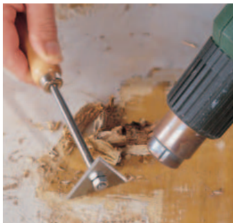
Unter Heißluft wird auch der härteste Lack weich und lässt sich leicht von der Oberfläche schaben.
