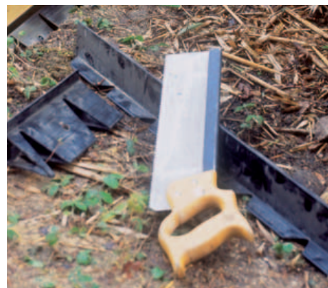
6 Als Randbefestigung dient hier das Kunststoffprofil Pave Edge (etwa 6,50 Euro per lfd.m). Es wird mit einer feinzahnigen Säge zugesägt.
