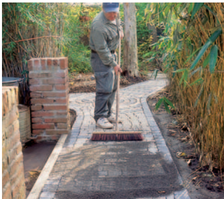
14 Jetzt wird wieder Splitt verteilt und eingefegt, bis die Fugen gefüllt sind. Das muss eventuell nach ein paar Wochen wiederholt werden.
