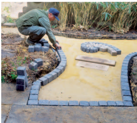
10 Die Randsteine werden in die Randprofile gelegt, damit das Muster sorgfältig auf die Randsituation abgestimmt werden kann.
