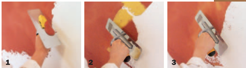
Beide Farbtöne auf die Glättkelle nebeneinander aufgeben (1). In kurzen, wechselnden Zügen aufglätten (2). Sofort im nassen Zustand die Übergänge verglätten (3).
