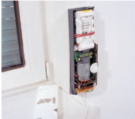
6 Anschließend den Gurtwickler in das Gehäuse einschieben und ausschließlich mit den beiliegenden Schrauben fixieren.
