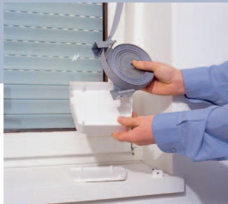
2 Nun den Gurt vorsichtig herausnehmen. Achtung! Verletzungsgefahr: Die vorgespannte Wicklerfeder behutsam entspannen.
