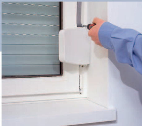
1 Als erster Schritt wird der Rollladen ganz heruntergelassen und der vorhandene Gurtwickler gelöst beziehungsweise demontiert.
