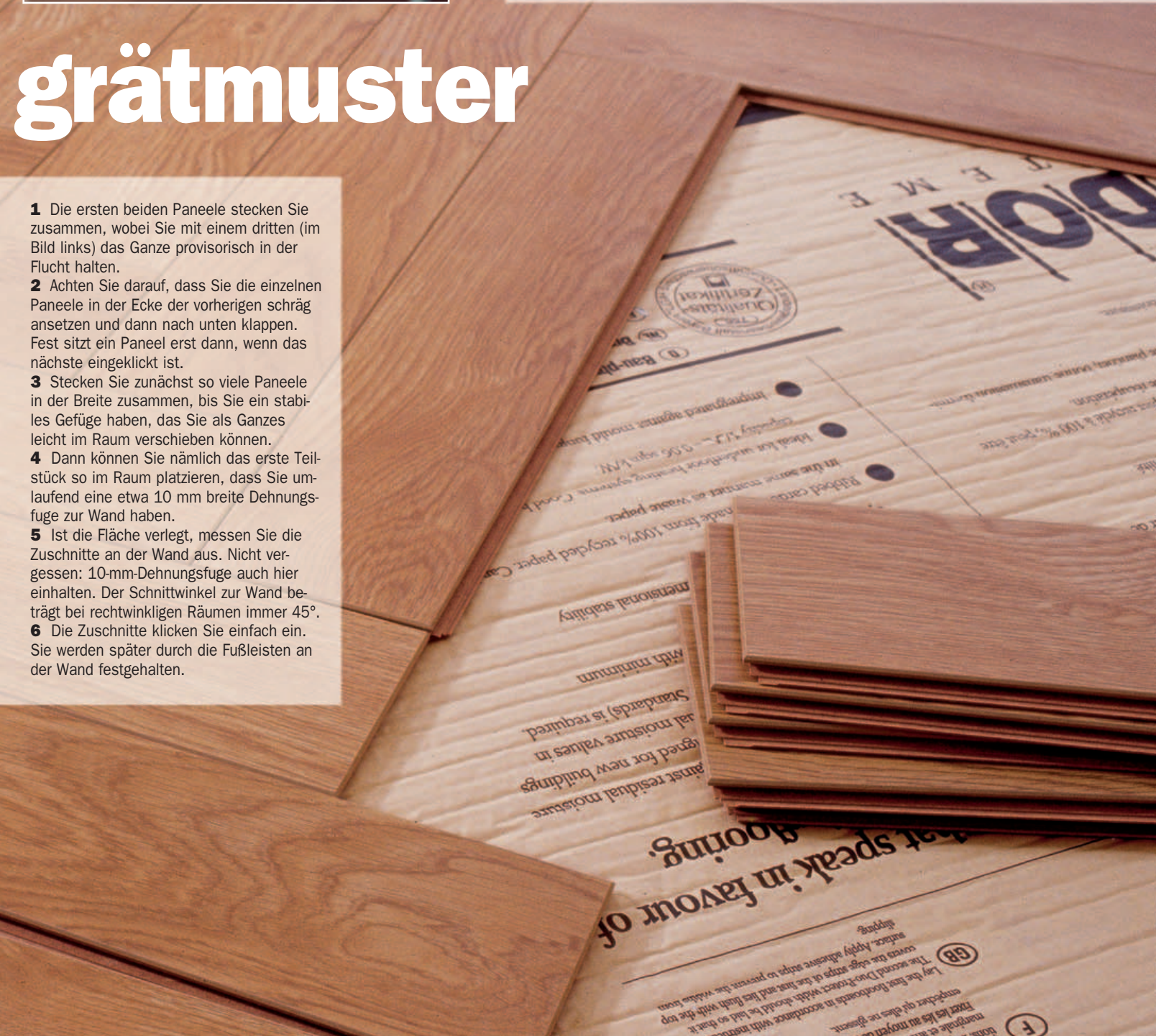
Eiche Parisienne: 8 mm starkes Laminat in Fischgrätverlegung
