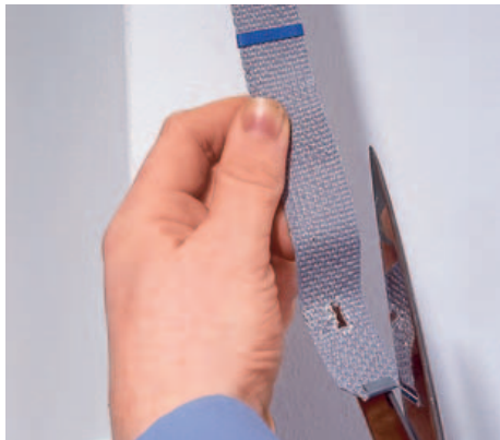
10 Befestigen Sie eine Markierung (hier blau) im Abstand von 18,5 cm auf dem Gurt, und schneiden Sie die Gurtecken unten schräg ab.
