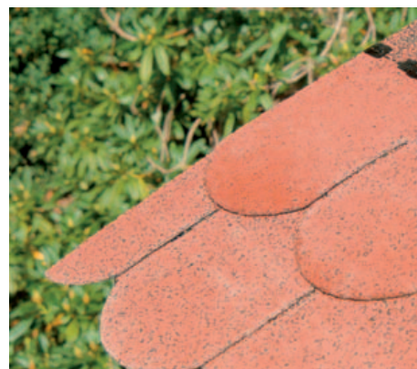
11 Jede weitere Reihe wird um eine zusätzliche halbe Schindel gekürzt. So entstehen keine Kreuzfugen an den Stößen der Schindelreihen.
