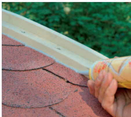
14 An Graten, wie hier an den Windbrettern, sorgt eine Abdeckleiste mit versiegelten Fugen für wasserdichten Anschluss.
