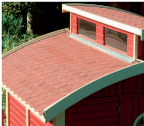
16 Die neue Deckung vertet den Gartenschuppen optisch auf und wird dessen Dach jahrelang vor Wind und Wetter schützen.
