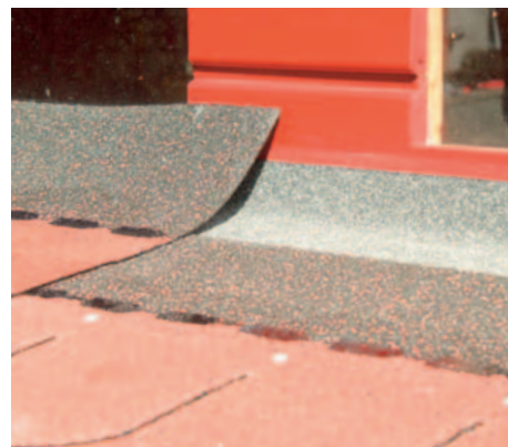
15 Stoßen die Schindeln am oberen Ende an eine Wand, wird die letzte Reihe hochgezogen und mit einem Abdeckprofil angeschlossen.
