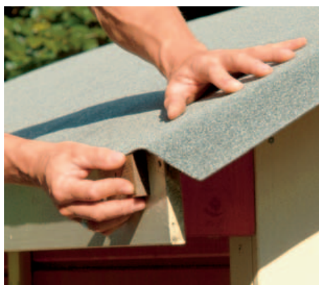
5 Die neue Deckung beginnt mit besandeten Bitumenbahnen als Unterdeckung, die traufseitig rund 2 cm überstehen soll (Hilfsklotz).
