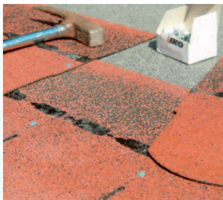
10 Die Nagelreihen sollten etwa 25 mm über den Schlitz zwischen den Schindeln sein. Etwas höher funktioniert aber auch.
