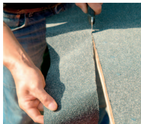
6 Der Überstand am Giebel wird am besten mit einem Hakenmesser bündig abgeschnitten. Hier stößt später das Windbrett gegen.
