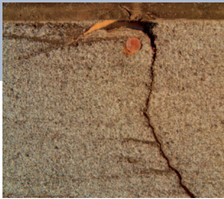
2 Eine einfache Lage „Teerpappe“ reißt bei mechanischer Belastung sehr schnell. Eine Reparatur mit Bitumenspachtel hilft nur kurzzeitig.
