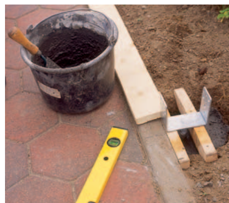
5 Den metallenen Pfostenschuh mit kleinen Hölzchen in Position bringen, fixieren und dann das Loch mit der Betonmischung verfüllen.
