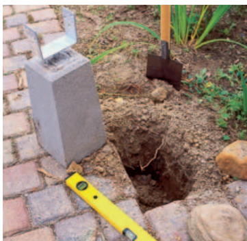
Fertige Betonsockel , in die die Pfostenschuhe einbetoniert sind, werden eingegraben und seitlich mit Sand festgestampft.
