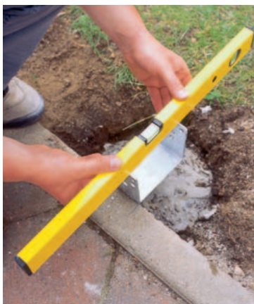
Die richtige Mischung: Perfekt für schwere Fundamente sind der Betonestrich plus Schnellbinder von Sakret. „Setz-Fix“ wird trocken ins Fundamentloch eingestreut und nur noch mit Wasser übergossen.
