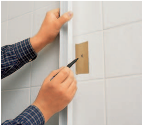
6 Ein Stück Paketklebeband auf den Fliesen verhindert, dass der Steinbohrer beim Ansetzen abrutscht und die Oberflächen zerkratzt.
