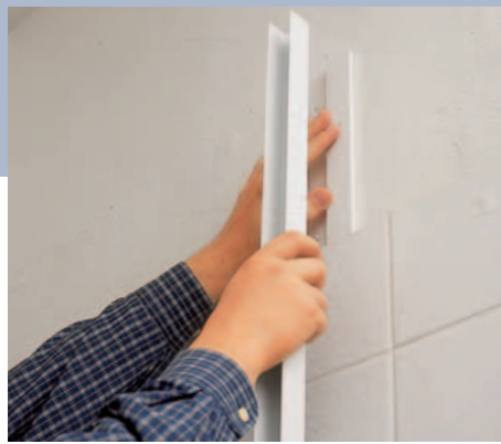
2 Eventuelle Absätze an der Wand, wie hier durch den niedrigen Fliesenschild, müssen mit hölzernen Distanzleisten ausgeglichen werden.
