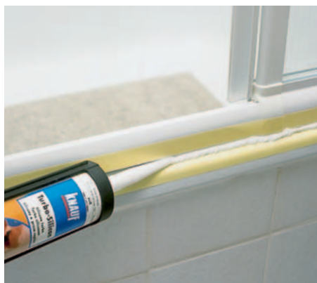
18 Das Silikon sorgfältig in die Fuge spritzen und dabei darauf achten, dass die Flanken von Wanne und Träger gut benetzt sind.
