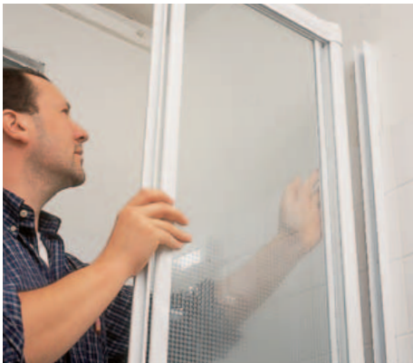
9 Nun die zwei Glaselemente (festes Teil mit Schiebetür) nacheinander in die Schienen schieben, jedoch noch nicht festschrauben.
