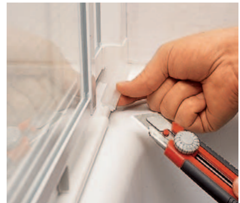
15 Durch Anpassen der Querträger an die Länge der Duschwanne entstehen Schlitzte, die mit einem Dichtprofil von innen geschlossen werden.
