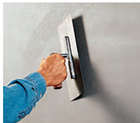
9 Nach dem Filzen kurz antrocknen lassen. Dann mit der Glättkelle ein- bis zweimal abziehen, bis eine glatte Oberfläche erreicht ist.
