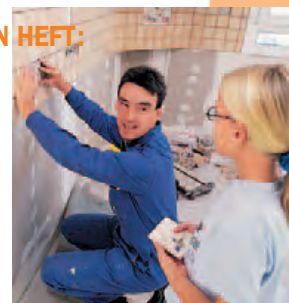
Gipskartonwände schrauben: Mit Helfer zum Fixieren ein Kinderspiel.
