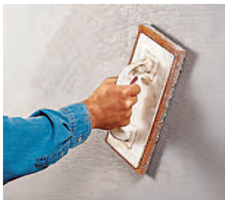
8 Putzauftrag anziehen lassen , dann anfeuchten und durch Reiben mit dem Schwammbrett oder dem Filzbrett aufschlännen.
