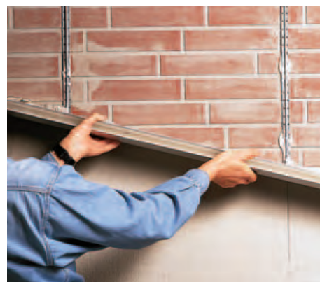
11 Lot- und fluchtgerecht montierte Putzleisten in regelmäßigen Abständen garantieren gleichmäßigen Auftrag. Ebenfalls am Vortag anbringen.
