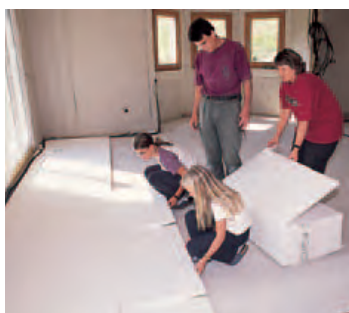
Trockenestrich verlegen: Geht schnell, macht allen Spaß!
