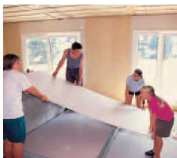
Perfekte Teamarbeit: Gipskartonplatten sind sperrig, aber nicht schwer.
