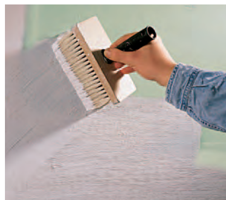
5 Bei Gips- und Gipsfaserplatten wird ein Putzgrund als Haftvermittler vor der Beschichtung mit mineralischen Dekorputzen verwendet.
