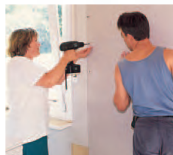
Gipskartonwände schrauben: Mit Helfer zum Fixieren ein Kinderspiel.
