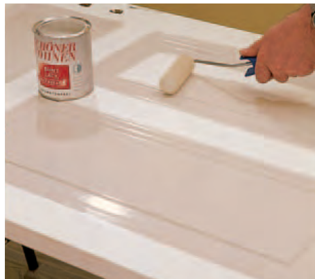
15 ...dann die Füllungen. Während beim Vorstrich eine Schaumrolle benutzt wurde, kommt jetzt eine beflockte Schaumrolle zum Einsatz.
