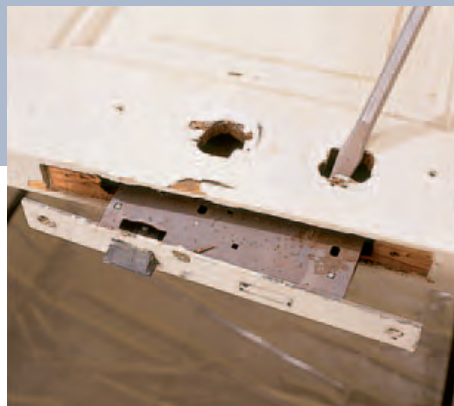
3 Das oft sehr eng eingebaute Schloss geht schwer herauszuziehen. Mit einem alten Schraubendreher durch das Schlüsselloch nachhelfen.
