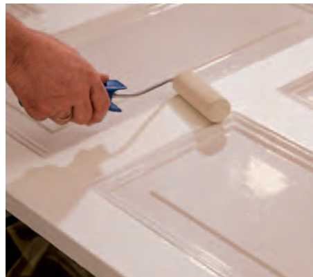
16 Dieses Arbeit ist die gleiche wie beim Vorstrich, auch hier wird zum Schluss die Umrahmung der Füllungen lackiert.
