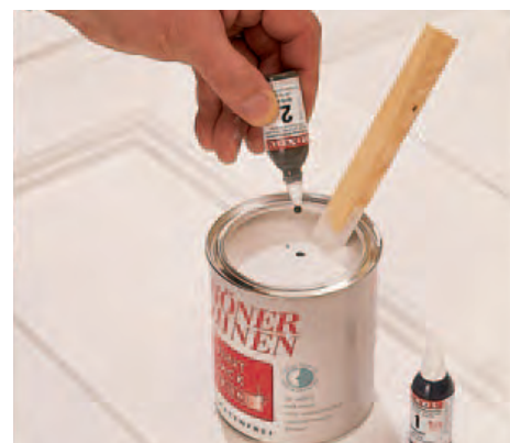
13 Ein alter Trick der Malerprofis: Tönen Sie den Weißlack mit etwas Schwarz oder Umbrablau ab. Sie werden sehen, er deckt viel besser.
