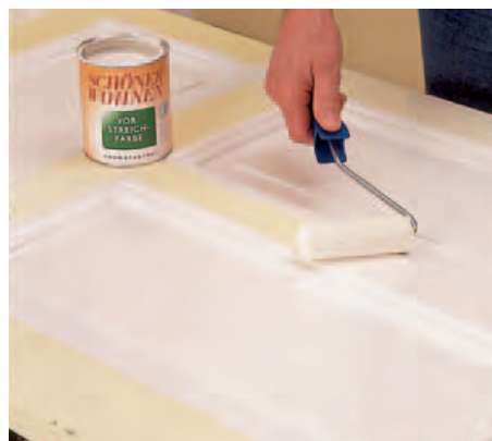
11 Zum Schluss werden die Rahmen um die Füllungen herum vorgestrichen. Den Vorlack zügig und gleichmäßig mit der Rolle verteilen.
