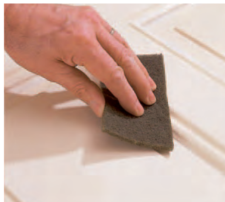
8 Ist der alte Lack hart und fest, braucht er nur mit einem feinen Schleifpad angeschliffen zu werden. Wichtig: Gründlich entstauben!
