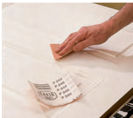
12 Der getrocknete Vorlack (Trockenzeit etwa sechs Stunden) wird mit feinem Schleifpapier (240er) zwischengeschleift, dann entstaubt.
