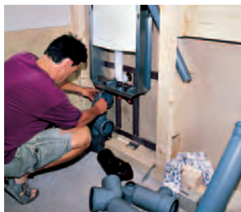
Sanitärinstallation: Vor der Vorwandinstallation steht das Teile-Puzzle...
