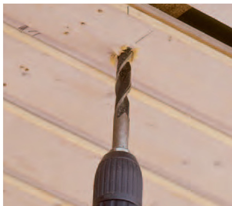
4 Um die Schalbretter nicht zu spalten werden sie mit einem 14-mm-Bohrer aufgebohrt. Dann passt der Metallbolzen problemlos durch.
