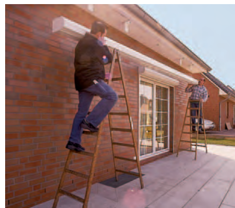
10 ... sie auf den Schulter bis unters Dach und hängt sie dann in die Konsolen ein. Bei dieser Arbeit sind Geschick und Kraft gefragt.
