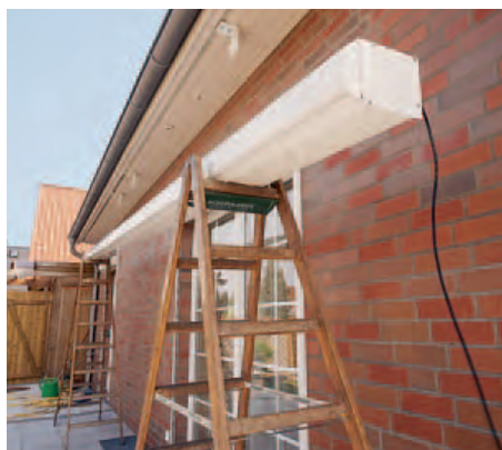
9 Das große Gewicht (bei 6 m Länge etwa 100 kg) macht die Markise unhandlich. Deshalb legt man sie zunächst auf zwei Leitern, hebt ...
