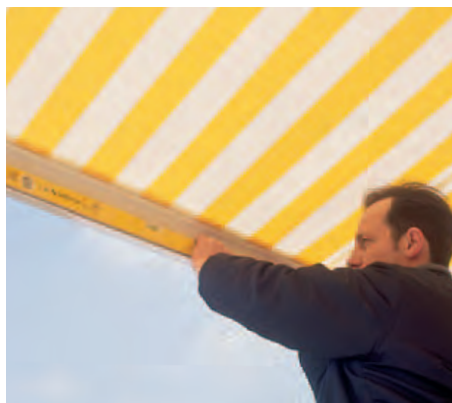
13 Außerdem kontrolliert der zweite Mann die Neigung der Fallstange mit der Wasserwaage, während die Position der Markise eingestellt wird.
