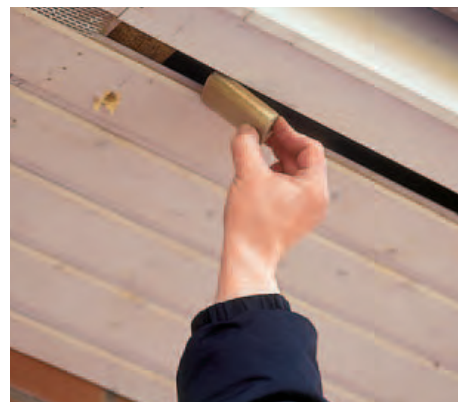
5 Da zwischen Schalbrettern und Sparren ein Zwischenraum ist, wird ein Holzstück eingeschoben, um den Druck der Markise aufzufangen.
