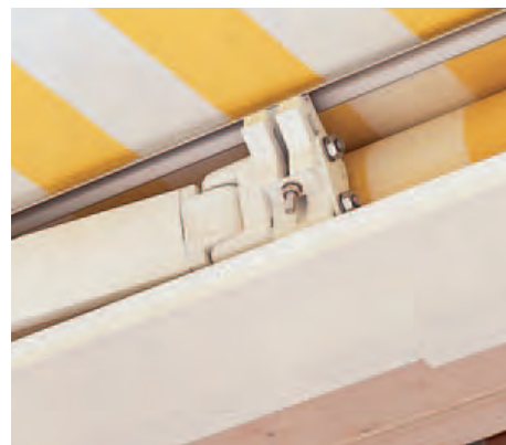
14 Hier wird die Neigung eingestellt: Die Markise anheben, die zwei Klemmschrauben rechts lösen, dann mit der Einstellschraube justieren.
