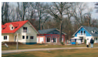
Twin Häuser in der Ausstellung von WeberHaus bei Kehl am Rhein.
