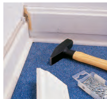
Die fertig gestrichenen Leisten mit dünnen Nägeln auf die vorhandene Sockelleiste nageln.
