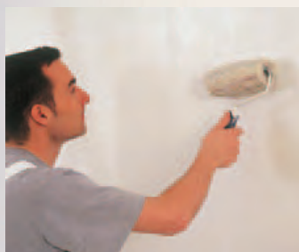
Der spezielle Vliestapetenkleister wird mit einer herkömmlichen Fellrolle auf die Wand gekleistert.
