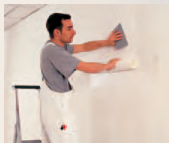
Direkt von der Rolle bettet man die Tapete anschließend auf die Wand in den Kleister ein. Fertig.
