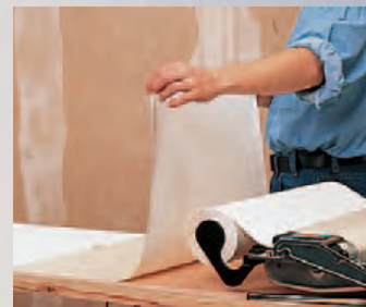
Bei beiden Kleistertechniken schlägt man die Bahnen von beiden Enden her zum Durchweichen ein.
