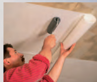
Arbeiten an der Decke werden auf dieselbe Weise ausgeführt: Tapete mit der Gummirolle andrücken.
