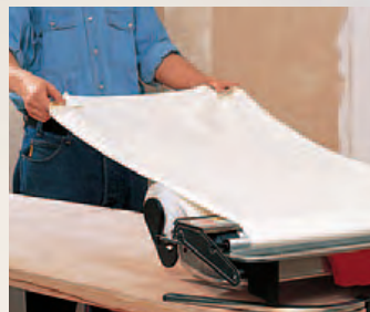
Mit der Kleistermaschine geht es schneller. Die trockene Bahn wird dabei durch das Gerät gezogen.
