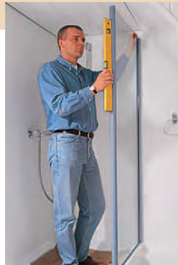
Duschkabine einbauen
