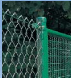
Maschendraht wird an gespannten Drähten aufgehängt. Er bietet die preiswerteste Möglichkeit, das Grundstück einzufrieden.
