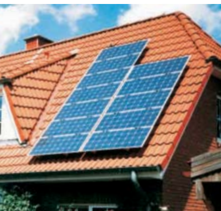
Die klassische Variante: Auf die Dachfläche werden je nach Bedarf Photovoltaik-Module montiert.
