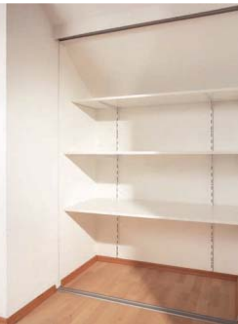
Die Regale sind an der Rückwand über Schienen befestigt und springen etwa 10 cm von der Schiebetür zurück.
