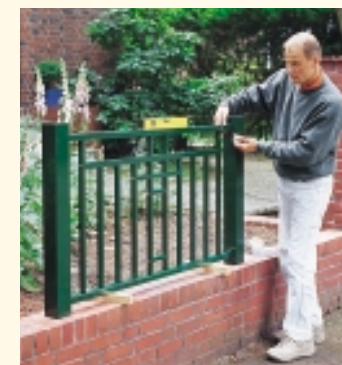
Eine Wasserwaage ist unentbehrlich, um die Bohrlöcher an den Pfosten präzise zu markieren. Dabei wird das Zaunfeld mit Keilen fixiert.
