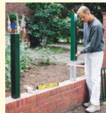
Die Pfosten werden über den Schuh geschoben. Es bleibt Spielraum, um mögliche Unebenheiten im Sockelbereich auszugleichen.
