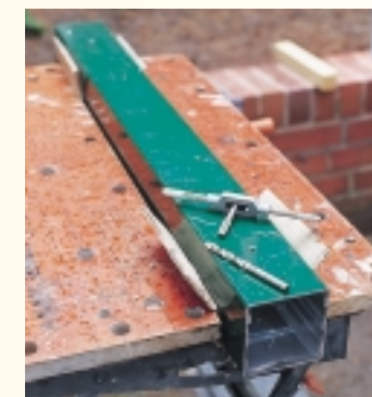
Eine stabile Unterlage gibt dem Alupfosten Halt beim Bohren und Gewindeschneiden. Alle Bolzen und Muttern sind aus Edelstahl.
