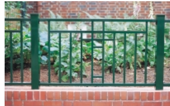
Das alte Ziegelmauerwerk musste vor der Montage teilweise neu verfugt und ausgebessert werden.
