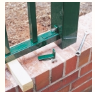
Die Befestigungswinkel werden in die Rahmenprofile geschoben und mit Bolzenschrauben in die Alupfosten geschraubt.
