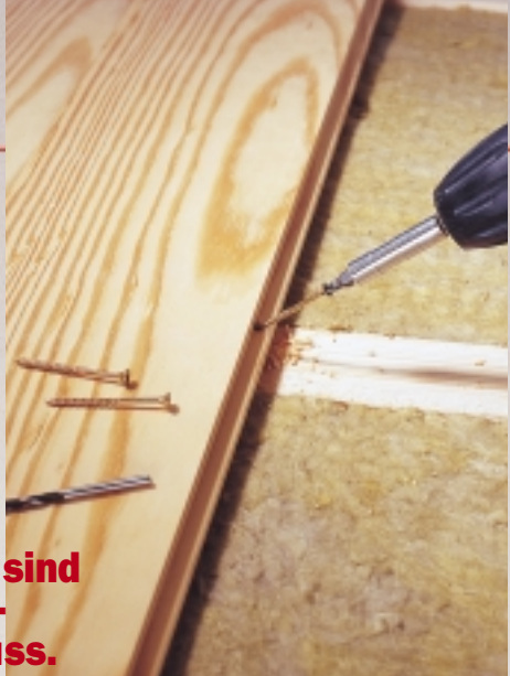
Die Verbindung der Dielen übernehmen beim klassischen Massivholz die Schrauben. Sie werden durch die Federn in die Traghölzer gesetzt. Die Dielen selbst verbinden Sie nicht fest miteinander, um Schwindrisse zu vermeiden.
