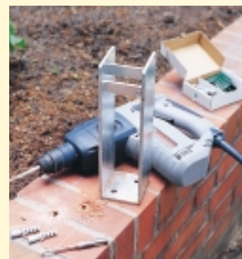
Die Stahlschuhe für die Alupfosten sind feuerverzinkt. Sie werden mit Edelstahlschrauben auf den Mauersockel gedübelt.
