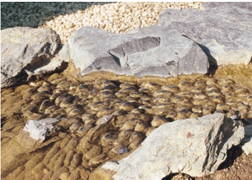
Die länglichen Kiesel sind in Fließrichtung verlegt. Dadurch ergibt sich eine perlige Wasseroberfläche. Wer keine Folie verwenden will, kann auch ein 5 bis 10 cm dickes, mit Armierungsstahl versehenes Betonbett anlegen.
