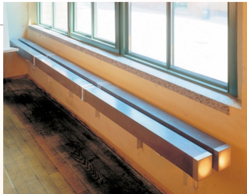
Aus Betonelementen zusammengesetzt: Eine spartanische Sitzbank, die behagliche Strahlungswärme an den Benutzer abgibt.
