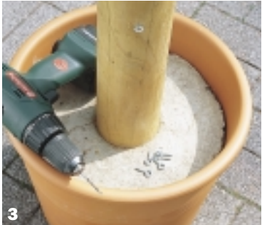
Ein solides Fundament aus Schnellzement gibt der Kräutersäule innerhalb weniger Minuten die nötige Standfestigkeit. Dazu wird der Topf mit einem Müllbeutel ausgekleidet, der das Abfließen des Zements verhindert.
