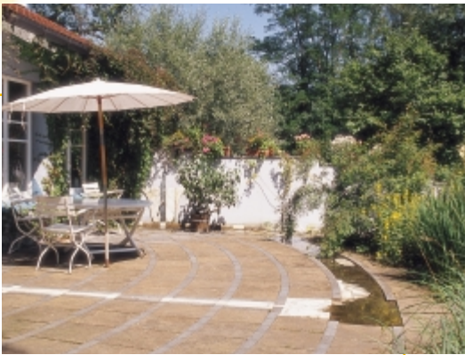
Die länglichen Kiesel sind in Fließrichtung verlegt. Dadurch ergibt sich eine perlige Wasseroberfläche. Wer keine Folie verwenden will, kann auch ein 5 bis 10 cm dickes, mit Armierungsstahl versehenes Betonbett anlegen.
