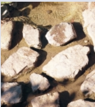
Pflaster im Wasser Flache Wasserläufe werden mit Inseln von lose verlegten Steinen interessanter: Die Fließgeschwindigkeit ändert sich und es gibt schöne Lichteffekte. Die Steine liegen auf Sand, der mit Tonmehl gemischt und dadurch sehr fest ist. Wenn die Steine als Weg durchs Wasser genutzt werden, nimmt man dicke Natursteinplatten oder Natursteine mit einer flachen Seite, die von unten mit Sand unterfüttert werden.
