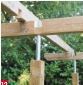
12 Sind die Pfosten im Boden ausgerichtet und verankert, stecken Sie Aluhülsen, Unterlegscheiben und Traghölzer auf die Gewindestangen.
