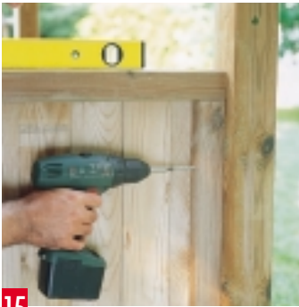
15 Die Seitenwände verschrauben Sie ebenfalls mit Spaxschrauben an den Pfosten. Kontrollieren Sie dabei stets die Waagerechte.
