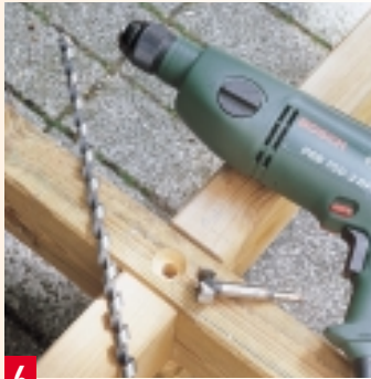
6 Bohren Sie die Tragholzüberblatungen in Gewindestangenstärke durch. Auf den Oberseiten Sackloch zum Versenken der Mutter bohren.
