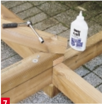
7 Auch der Pfettenkranz wird an den Stößen überblattet. Die Verbindung und die Gratsparren werden miteinander verleimt und verschraubt.
