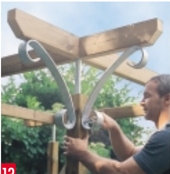
13 Nach dem Anziehen der Muttern verschrauben Sie an jeder Ecke je zwei verzinkte Ziereisen als Aussteifungselemente an die Pfosten.
