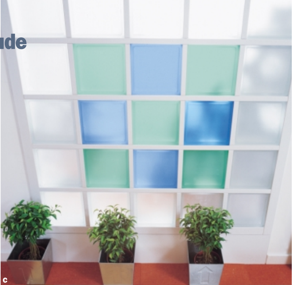
Lichtbänder aus Glasbausteinen können mehr als nur Tageslicht in dunkle Ecken bringen: Kombinationen von weißen oder klaren Steinen mit farbigen Exemplaren können, je nach Lichteinfall, schöne Farbspiele erzeugen. Gleichmäßig verteilte Steine (A) schaffen lebhaftes Schattenspiel, bunte Glasfelder oder -rahmen sorgen für dezente Farbstimmungen (B + C) .
