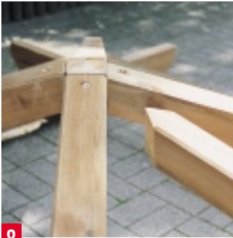
8 Am Firstpunkt laufen die Gratsparren gegen einen senkrechten Firstpfosten, die Normalsparren müssen dazwischen eingepasst werden.
