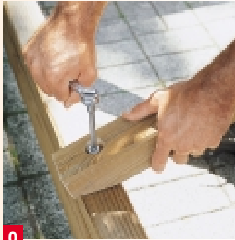
9 Die Normalsparren fixieren Sie mit Sechskant-Holzschrauben am Pfettenkranz. Auch hier Sackloch zum Versenken der Schrauben bohren.
