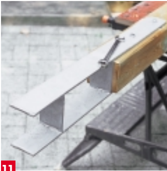
11 Am unteren Ende der Pfosten montieren Sie je einen Pfostenanker mit je zwei Schlüsselschrauben. Den Anker dabei genau fluchten.
