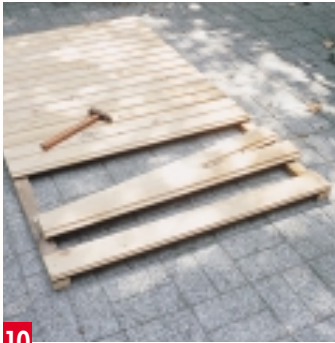
10 Die Verbindung aus einem Dachlattenrahmen und darauf vernagelten senkrechten Profilbrettern ergibt unsere beiden Seitenwände.
