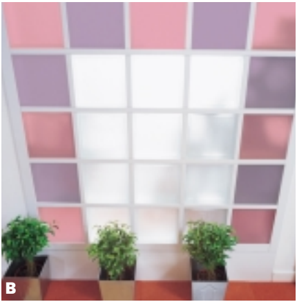
Lichtbänder aus Glasbausteinen können mehr als nur Tageslicht in dunkle Ecken bringen: Kombinationen von weißen oder klaren Steinen mit farbigen Exemplaren können, je nach Lichteinfall, schöne Farbspiele erzeugen. Gleichmäßig verteilte Steine (A) schaffen lebhaftes Schattenspiel, bunte Glasfelder oder -rahmen sorgen für dezente Farbstimmungen (B + C) .
