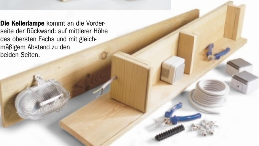
An der Vorderseite der Mittelwand wird hinter dem Fach für die Steckdosen und Schalter eine Verteilerdose angebracht. Für die Kabelführungen müssen entsprechend große Löcher gebohrt werden.
