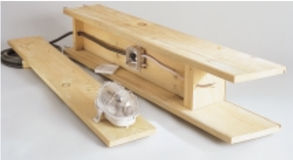
Die Kellerlampe kommt an die Vorderseite der Rückwand: auf mittlerer Höhe des obersten Fachs und mit gleichmäßigem Abstand zu den beiden Seiten.
