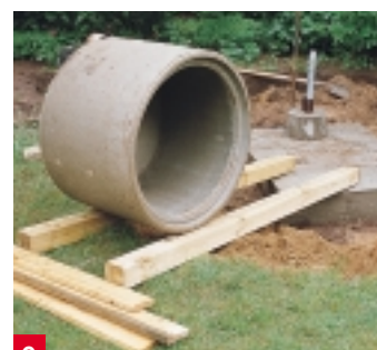
9 ...der dem Durchmesser des Fertigbetonrings entspricht. Über zwei Kanthölzer rollen Sie den auf das Fundament und richten ihn dort aus.
