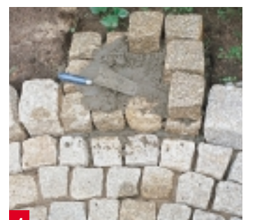
4 Die Randsteine sind 20 x 20 cm groß. Der kleine Sockel auf der Rückseite des Brunnenplatzes wird ebenfalls aus Granitbossen gemauert.
