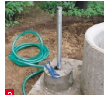
2 Das Rohr führen Sie durch das Kunststoffrohr, den Schlauch mit Fitting durch ein Loch unterhalb des Fundaments. Dort beide verschrauben.
