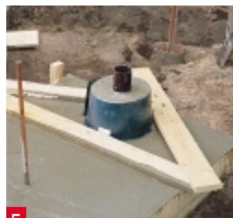
5 Auf dem frischen Beton stülpen Sie den Eimer über das Rohr und fixieren ihn mit Brettern in seiner Lage. Dann füllen Sie ihn mit Beton.
