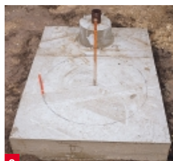
8 Hat der Beton abgebunden , schalen Sie Fundament und Sockel aus. Mit einem Bleistift markieren Sie einen Kreis um den Mittelpunkt...
