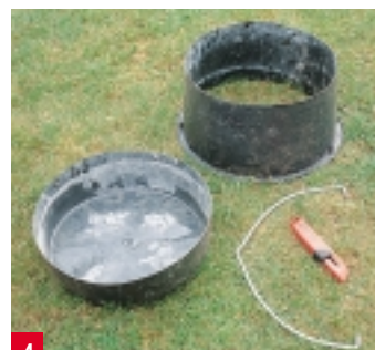
4 Aus einem alten Eimer schneiden Sie sich mit einem Cutter die Sockelschalung. Den Henkel müssen Sie natürlich abnehmen.
