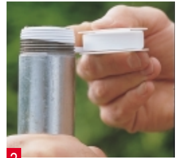
3 Das Rohrgewinde umwickeln Sie möglichst stramm mit einem Dichtband, bevor Sie das zweite Rohrteil aufschrauben.
