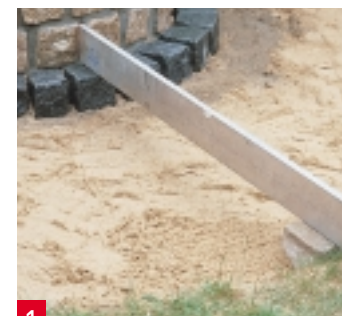
1 Das Loch füllen Sie mit Sand bis etwa Steinstärke unter die Grasnarbe auf und verdichten ihn. Die Fläche erhält 2 Prozent Gefälle nach außen.
