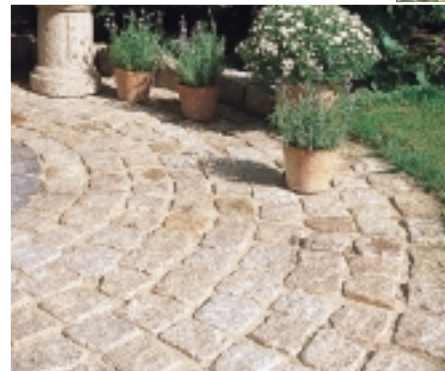
Die Fugen (Bild oben) sind bis etwa 1 cm unter Steinrand verfüllt. Über sie läuft das Regenwasser nach außen hin ab. Die Pumpe ist kinderleicht zu bedienen (Bild rechts).
