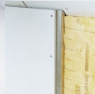
Die fertige Unterkonstruktion nimmt zusätzliche Wärmedämmung und Leitungen auf. Gipsplatten können Sie zum Dach hin mit dem Surfmobel anschragen.
