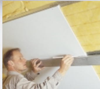
Ein Bleistiftstrich hilft beim Beplanken der Unterkonstruktion mit Fermacellplatten – Schraubabstand etwa 15 cm –, auch das verdeckte mittlere Profil zu treffen.
