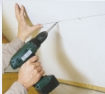
Spezielle Schnellbauschrauben sind für die Montage der Gipsfaserplatten erforderlich. Ohne vorzubohren schraubt man sie mit dem Akku- oder Schnellbauschrauber in die Profile.
