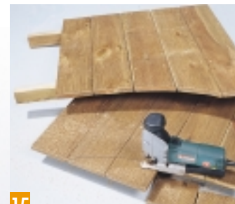
15 Den Zuschnitt der Seitenwände nehmen Sie erst nach der Verschallung der Rahmenkonstruktion vor. Auch er verläuft bogenförmig.
