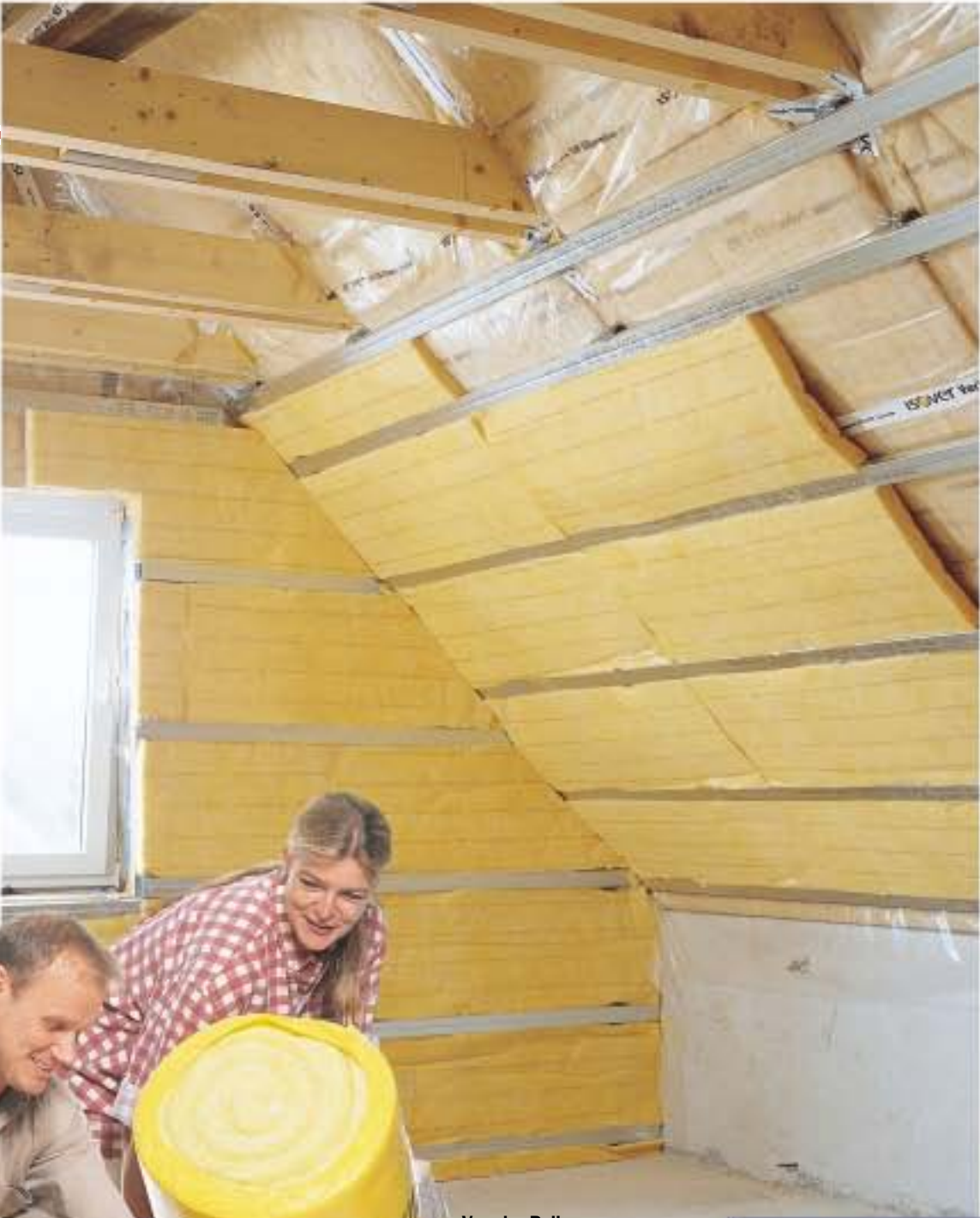
Von der Rolle sind nur die leichten Dämmplatten für Zwischen- und Untersparrendämmung.
