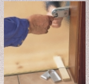
Außenseite: Die Klemmplatte wird per Inbusschraube auf das Flügelband geschraubt. Dann kann man die Abdeckkappe aufstecken.
