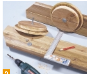
3 Die Räder montieren Sie mittig am unteren Konstruktionsholz der Tragelemente. Die Bohrpunkte zeichnen Sie mit Winkel und Bleistift an.
