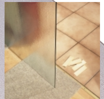
Die Beschläge werden an der stehenden Tür montiert. Schützen Sie die Kanten mit einem Teppichrest. Keile dienen zum Ausrichten.
