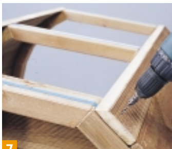
7 Der Kessel entsteht durch Verschalen der drei Bögen mit 94-mm-Brettern. Die beiden unteren Bretter werden dem Boden angepasst.
