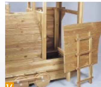
16 Als Einstiegshilfe verschrauben Sie noch eine kleine Leiter an die Seitenwand. Setzen Sie je zwei Schrauben durch die Sprossen.
