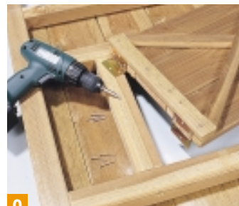
9 Im vorderen Rahmen montieren Sie die „Feuerklappe“ mit Messingscharnieren. Dazu setzen Sie Zwischenleisten in den Rahmen.
