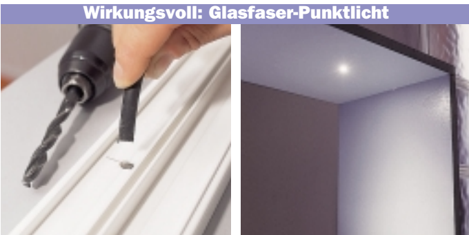
Die Glasfaserstränge werden für jede „X-Block“-Wand auf Maß gefertigt und können zusammen mit den Wandmaterialien bestellt werden. In den Projektor kann ein Farbrad integriert werden, das, über einen Motor angetrieben, die Lichtfarbe kontinuierlich ändert – oder auf Knopfdruck eine Farbe hält.
