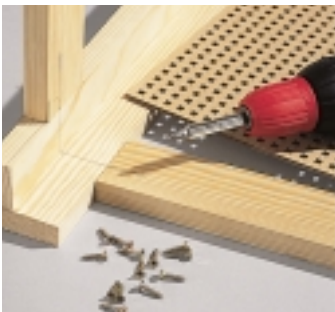
Die Rahmenfüllungen können aus allen wärmedurchlässigen Materialien sein. Sie werden mit etwa 2 cm Befestigungsüberstand montiert.
