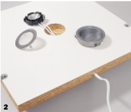
Mit einer Lochsäge ohne Zentrierbohrer schneidet man den Lochkranz aus. Dazu muss der Bohrständerfuß mit Zwingen an dem Regalboden festgesetzt werden. Man schneidet mindestens 16 mm tief und arbeitet den Bohrkern mit dem Beitel heraus.
