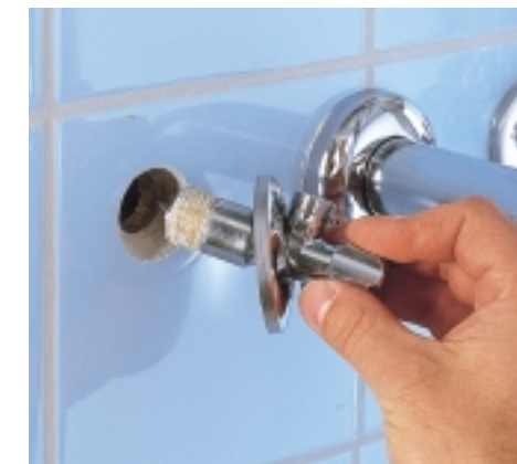
Mit aufgesetzter Wandrosette drehen sie nun das Eckventil wieder in den Wandanschluss, so dass der Armaturanschluss nach oben steht.
