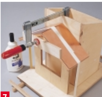
7 Pressen Sie das Satteldach beim Verleimen mit der Zwingge gegen das Haupthaus. Ein Klebebandstreifen sichert den Dachwinkel.
