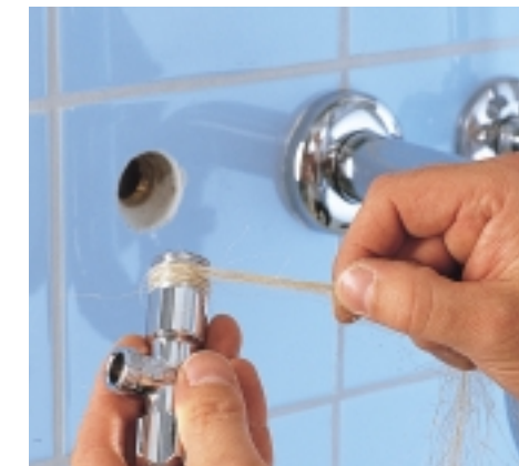
Wickeln Sie eine dünne Strähne Hanffaser ums Gewinde, so dass es sichtbar bleibt. Bleiben die hinteren Gewindegänge frei, ist es perfekt.
