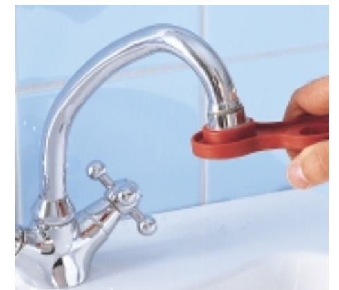
Mit Spezialschlüssel den Perlator der Zapfarmatur entfernen, Leitung spülen – kurz Zapfventile öffnen – und den Perlator wieder installieren.
