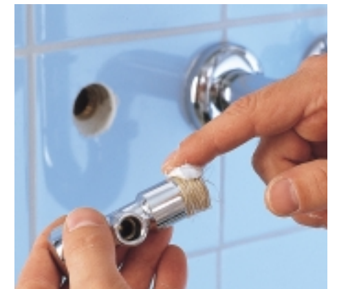
Eine Dichtungspaste wird dünn auf das Gewinde gestrichen. Profis machen dies vorm Umwickeln mit Hanf, es geht aber ebenso gut andersrum.
