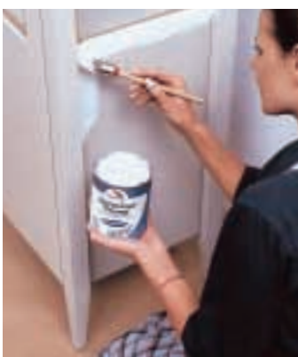
An den Übergängen zwischen benachbarten Flächen, in Ecken und Profile wird der Lack mit einem Ringpinsel aufgetragen.
