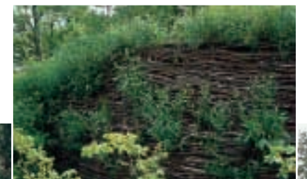
Grüne Architektur: Aus Weidengeflecht auf den Außenseiten und einer Füllung aus Erde entsteht eine dicke, stabile Wand (rechts). Die schöne, geformte Hainbuchenhecke ist Schmuck und Schutz gleichermaßen (unten).
