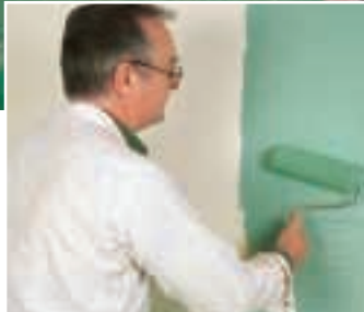
Die fertig tapezierte Wand wird nach dem Trocknen des Tapetenkleisters durchgehend gestrichen.
