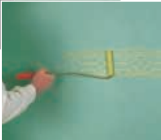
Ein zweiter Farbton, mit einer ausgewalzten Lammfellrolle auf die erhabenen Stellen der Bordüre aufgetragen, erzielt einen noblen Effekt.
