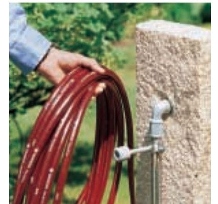
Für den Fall, dass der Schlauch nicht gebraucht wird, ist auf den Rückseiten der Säulen jeweils ein kleiner Schlauchaufhänger montiert.
