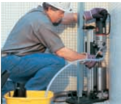
Kernlochbohrungen werden im Nassbetrieb durchgeführt. Wegen des aufwendigen Maschinenparks ist das eine Arbeit für Spezialunternehmen. (Metabo)
