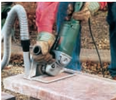
Beim Arbeiten mit großen Diamant-trennscheiben wird viel Staub aufgewirbelt. Selbst im Außenbereich ist das Arbeiten mit einer Staubabsaugung zu empfehlen.
