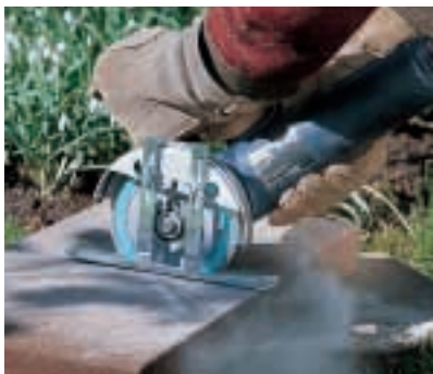
Um ein Verkanten der Scheibe zu verhindern, wird beim Trennen von Steinplatten ein Führungsschlitten eingesetzt. Die Platte wird angetrennt und dann gebrochen.
