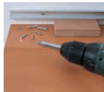
Das Aluminiumprofil mit Abstand zum Regal (ein Plattenrest dient als Lehre) an der Wand befestigen, Schraubenköpfe einsenken.
