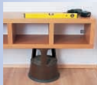
Ein Hocker ist ein nützlicher Montagehelfer. Reicht die Höhe nicht aus, können zum Beispiel Bücher die Position weiter erhöhen.
