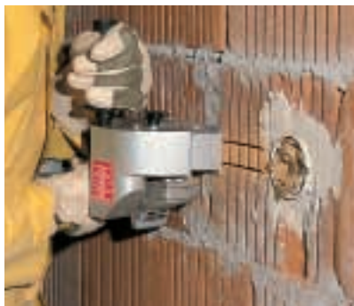
Mit der Mauernutfräse werden die Schlitzte gleichmäßig. Zwischen zwei Diamant-scheiben liegen auswechselbare Distanzstücke für unterschiedlich breite Schlitzte.
