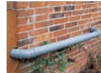
Das Verbindungsrohr auf der Mauerrückseite zwischen Filteranlage und Auslauf muss ein Gefälle von 1 bis 2 % aufweisen.
