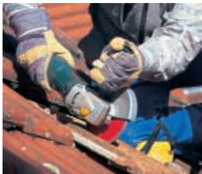
Die unterschiedlichsten mineralischen Baustoffe können mit Diamantwerkzeugen bearbeitet werden – vom harten Beton bis zum eher weichen Tonziegel.
