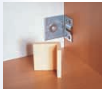
Die Montagewinkel werden in Bohrungen der Fachböden eingesetzt, der andere Schenkel des Winkels an die Wand geschraubt.
